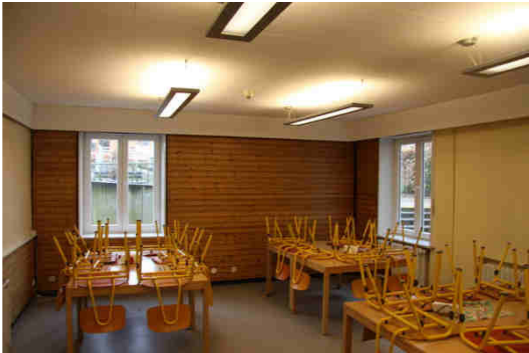
Bild 7: Speiseraum im Untergeschoß mit T5-Beleuchtung
