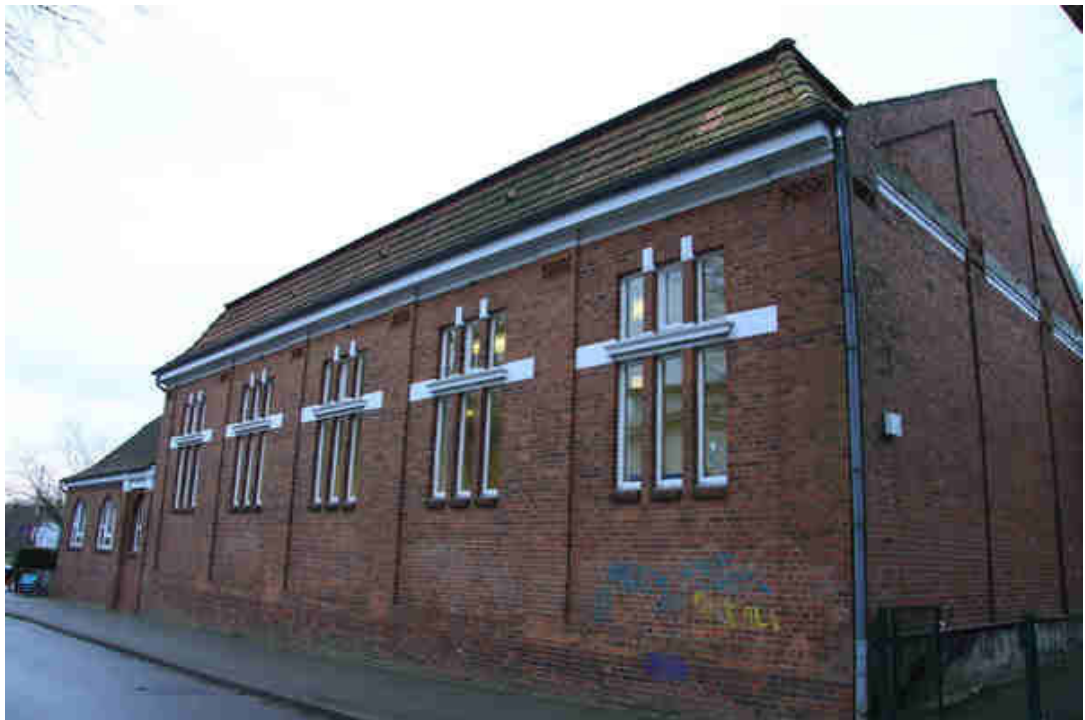
Bild 14: Nordseite der Turnhalle
