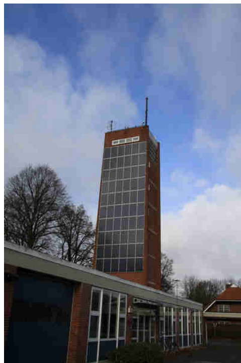
Bild 8: Südseite des Turms für die Trocknung der Schläuche mit Photovoltaikflächen
