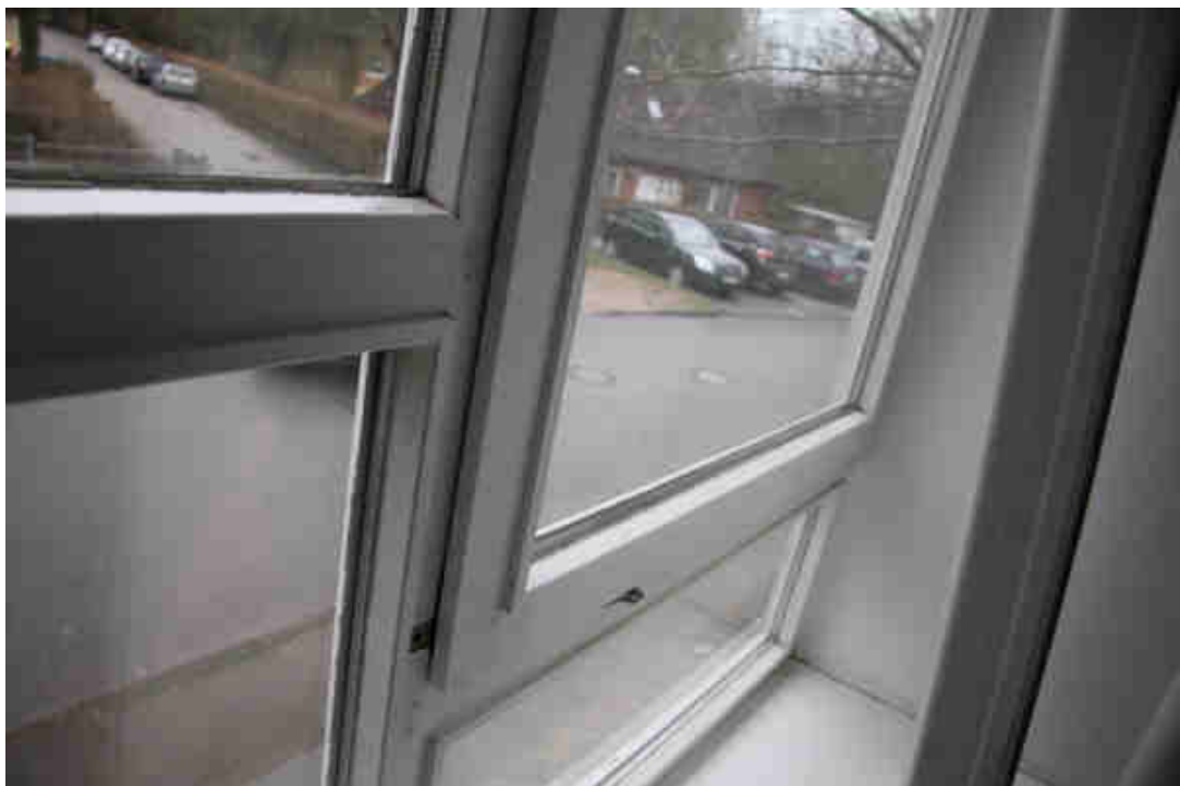
Bild 8: Iso-Verglasung mit Holzrahmen und Baujahr 1982
