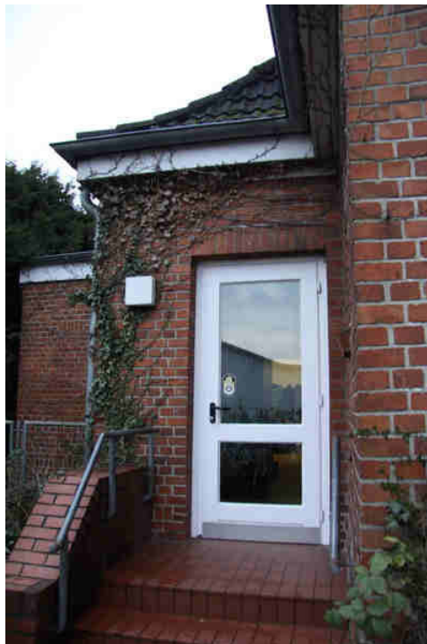
Bild 12: Zugang zu dem Umkleidebereich der Turnhalle auf der Ostseite
