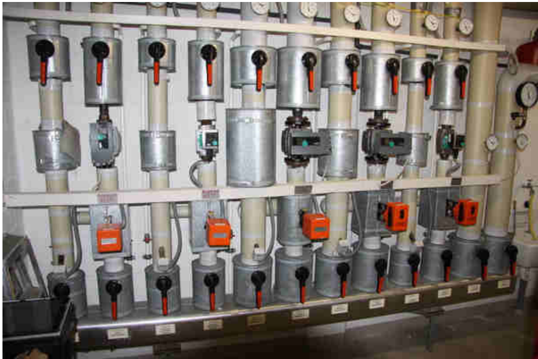
Bild 5: Heizungsverteilung
