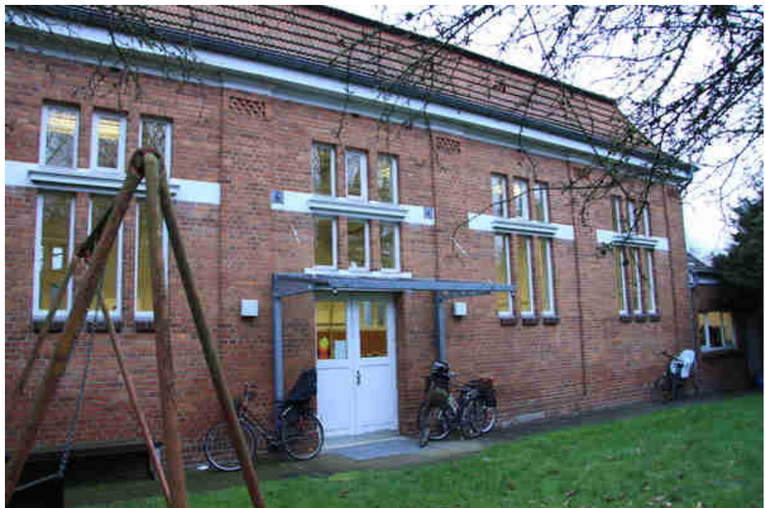
Bild 16: Südseite der Turnhalle mit Eingangstür zur Halle
