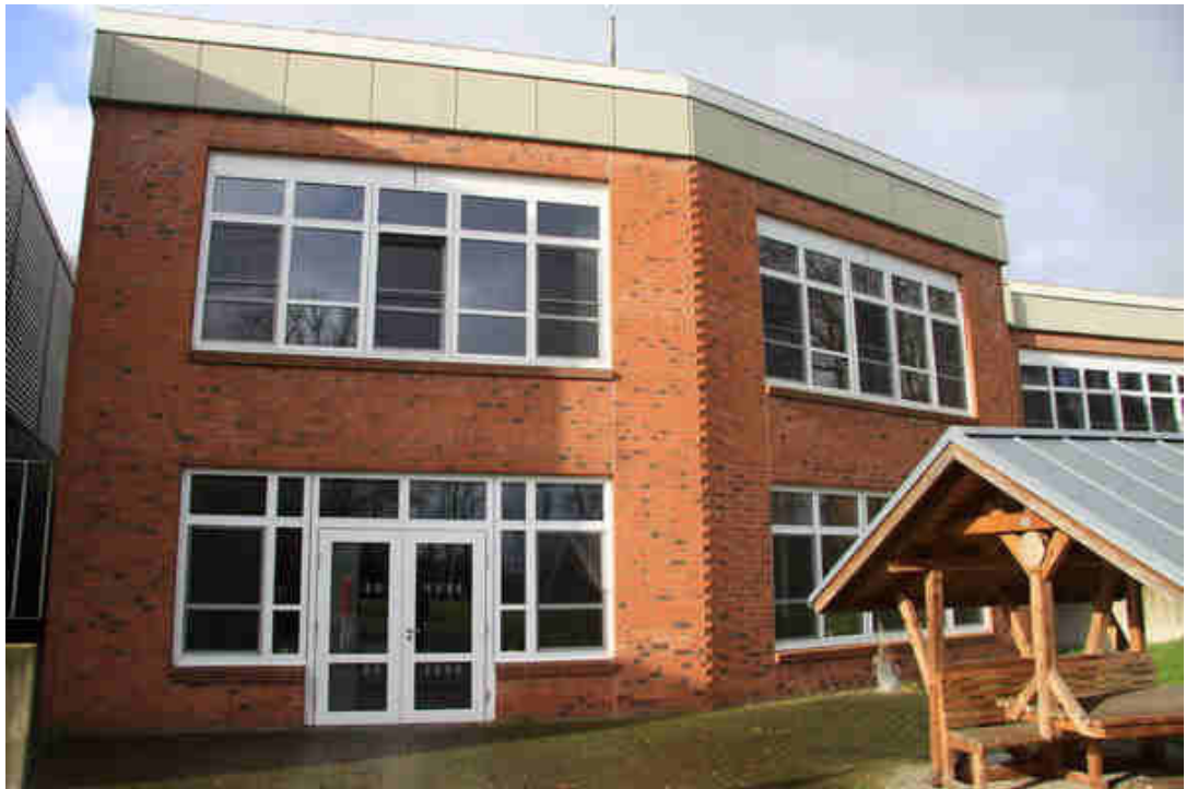
Bild 9: Ostseite mit dem Kantinenbereich im Untergeschoß und den südlichen Seminarräumen im Obergeschoß
