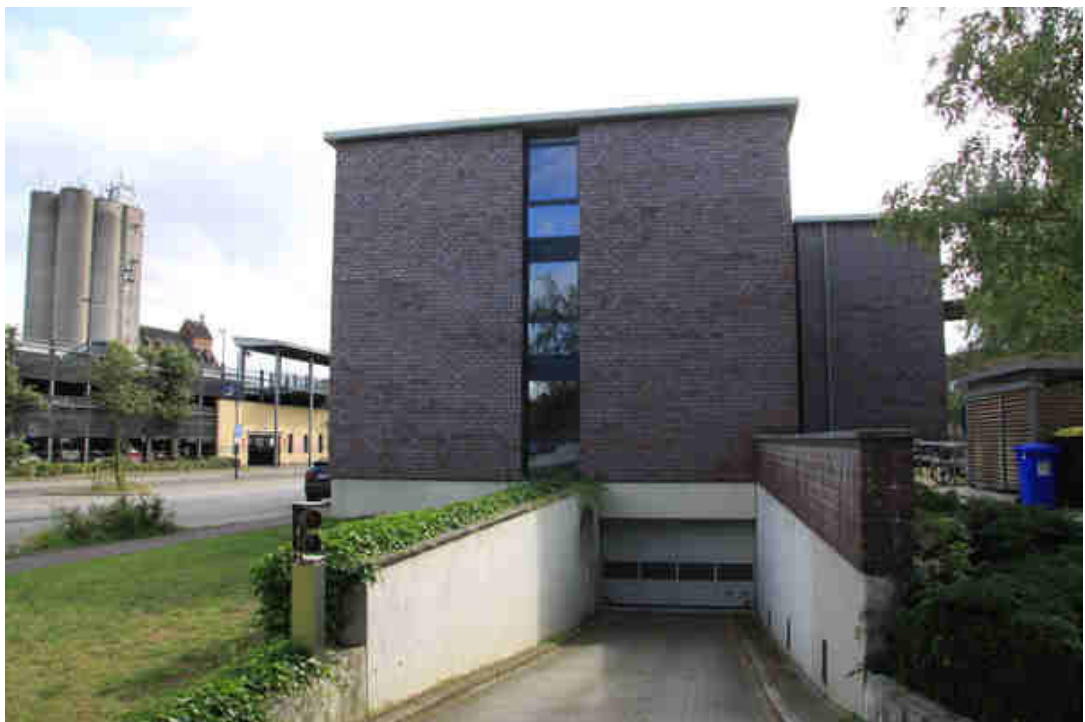
Bild 8: Ostseite des Gebäudes
