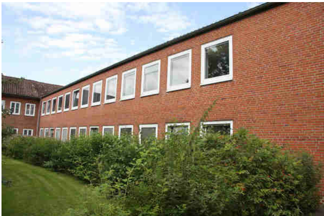
Bild 10: Süd-Ost Seite des Gebäudes C
