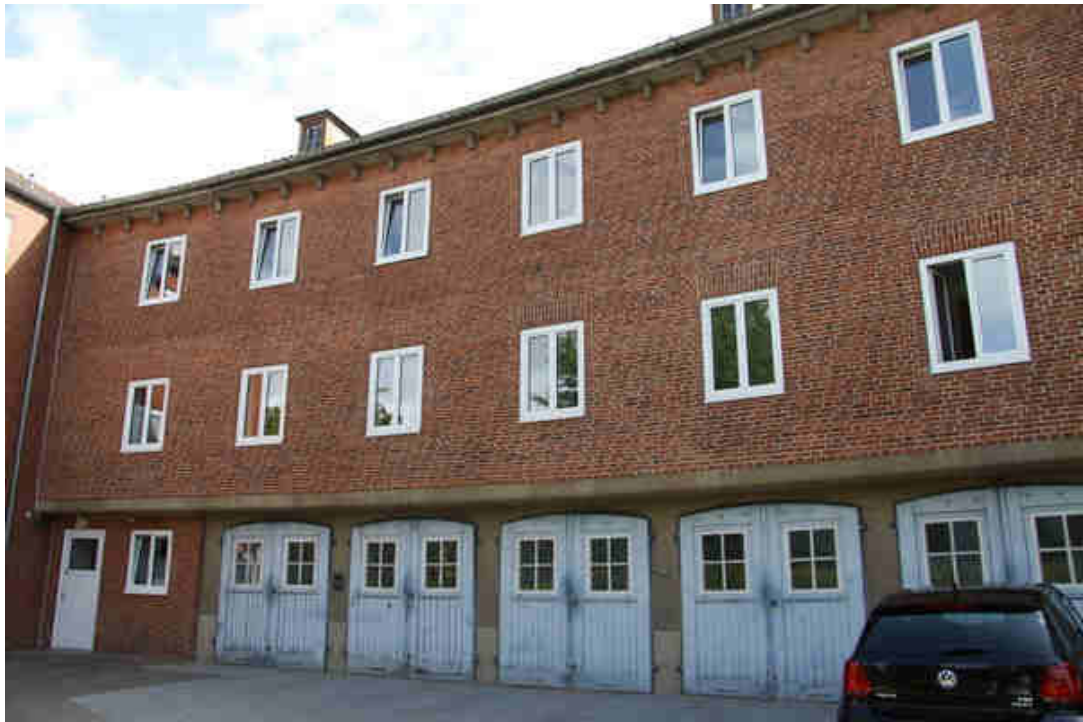
Bild 15: Nordseite des Verbindungstraktes A-C mit den hölzernen Garagentoren
