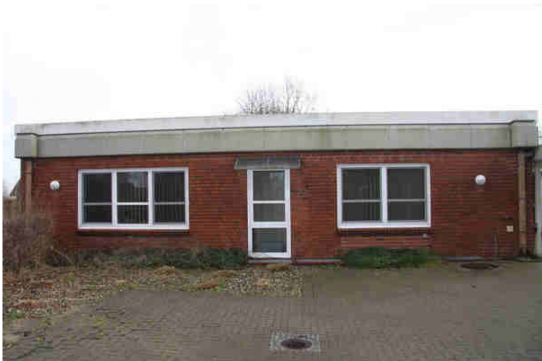
Bild 6: Westseite des nördlichen Bürobereiches
