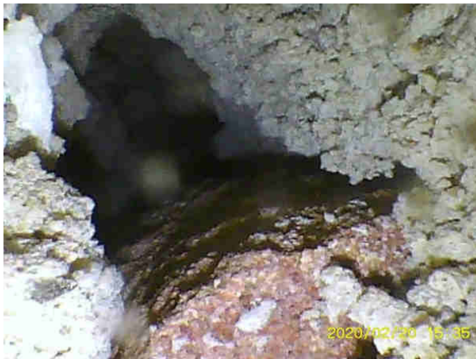
Bild 18: Mauerwerksuntersuchung ergab nur eine geringe Hohlchicht, Blickrichtung aufwärts zwischen Mauerwerk und Verblender
