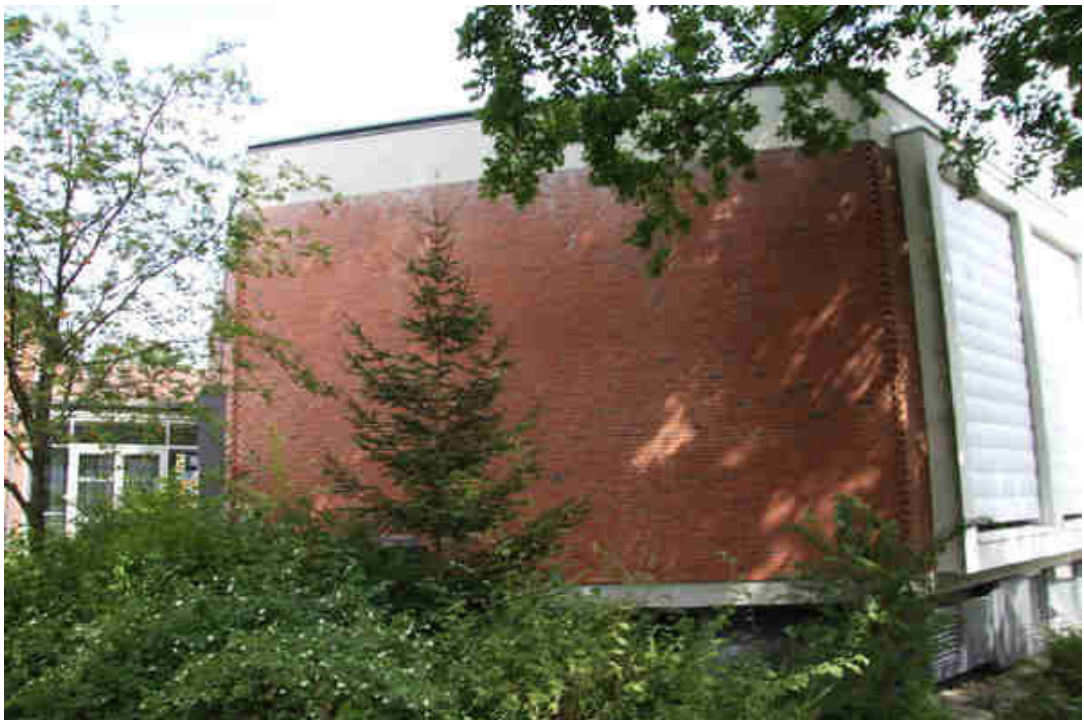
Bild 8: West-Seite des KT-Gebäudes
