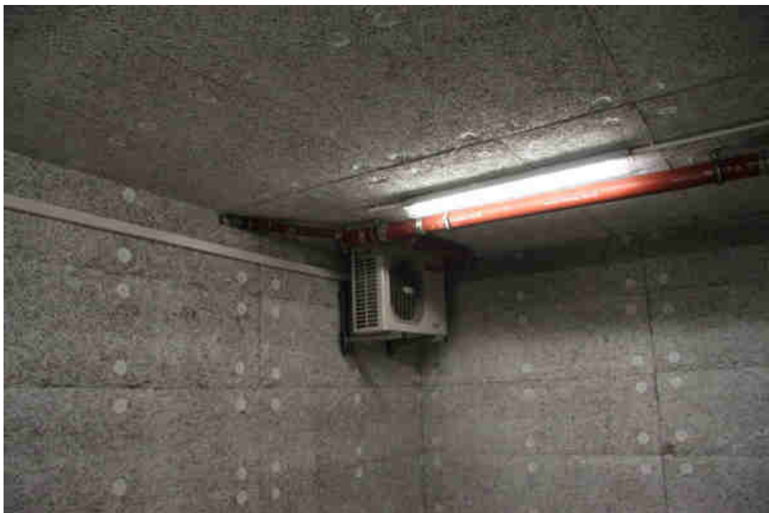
Bild 6: Decken- und Wanddämmung zu den beheizten Räumen neben und über der Tiefgarage
