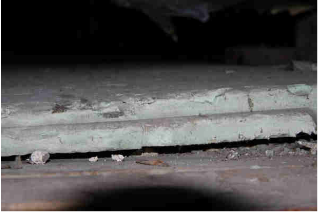
Bild 11: ca. 4 cm Dämmung aus Styrodur auf der Hallendecke
