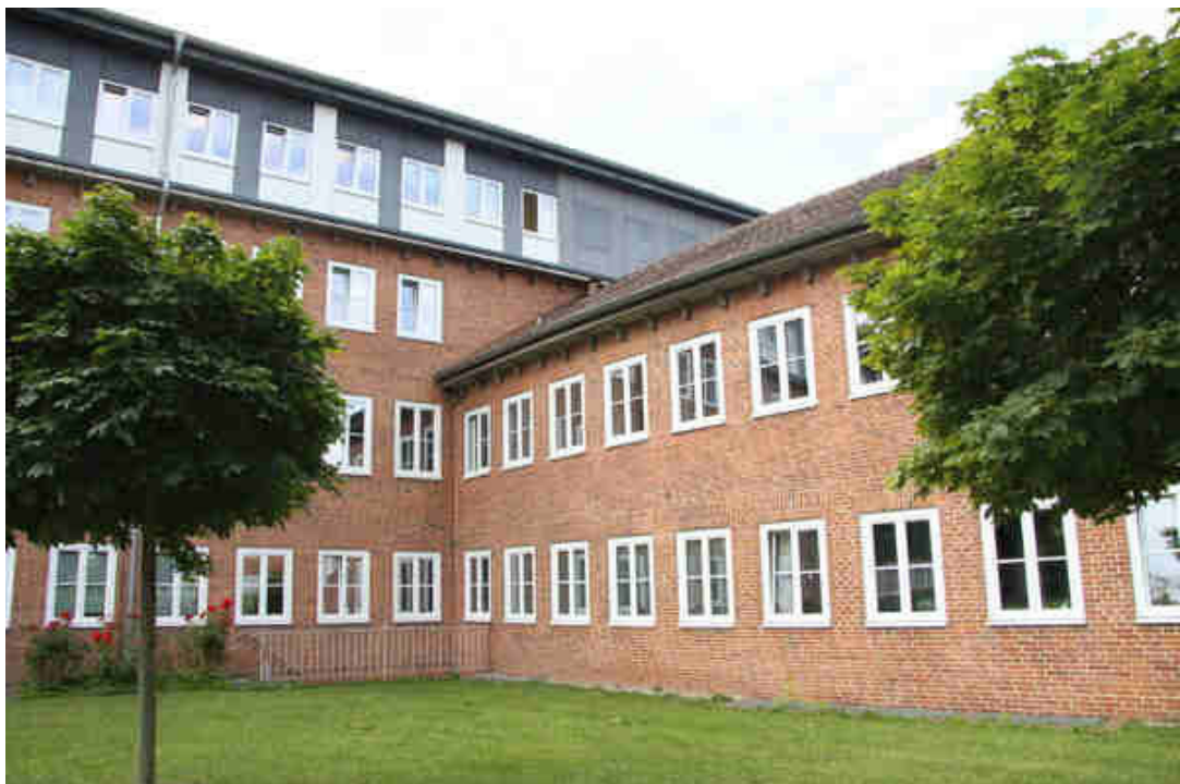
Bild 16: Südseite vom Verbindungsgebäude A-C
