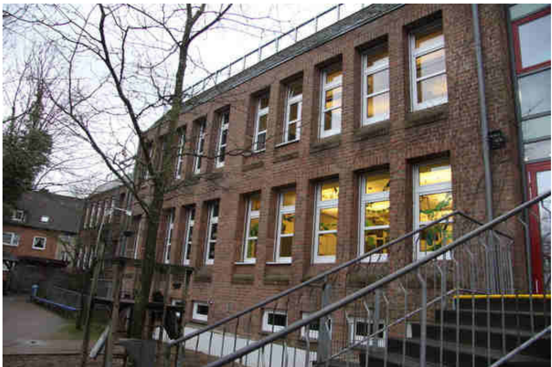
Bild 14: Ostfassade des BA 2
