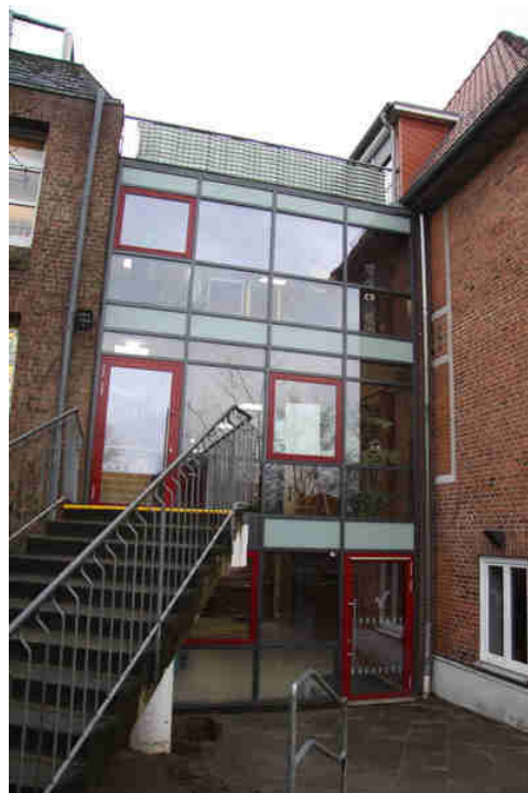
Bild 16: Östlicher Zugang vom Schulhof zur Eingangshalle im Erdgeschoss
