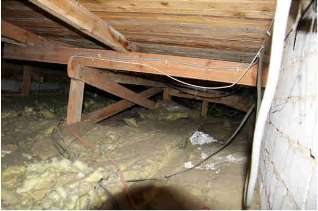
Bild 13: gedämmte oberste Geschossdecke
