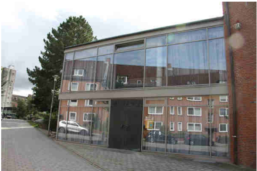
Bild 4: Glasfassade auf Nord-Ost Seite des KT-Gebäudes
