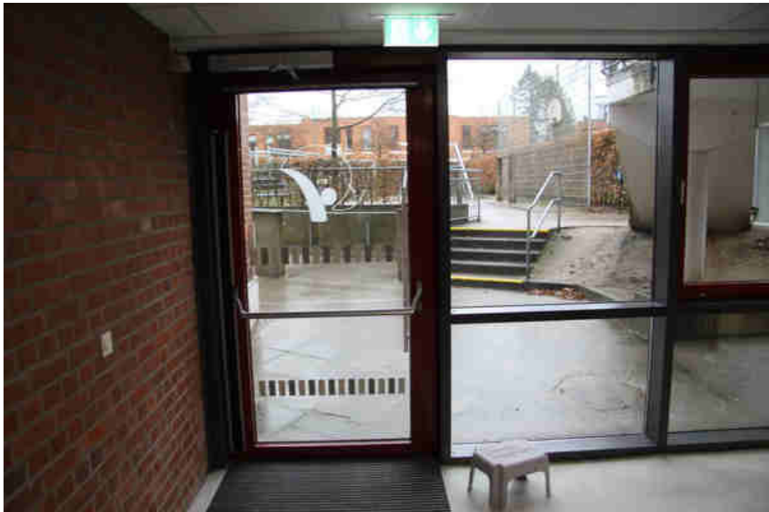
Bild 7: Östlicher Eingang vom Pausenhof in das Untergeschoß
