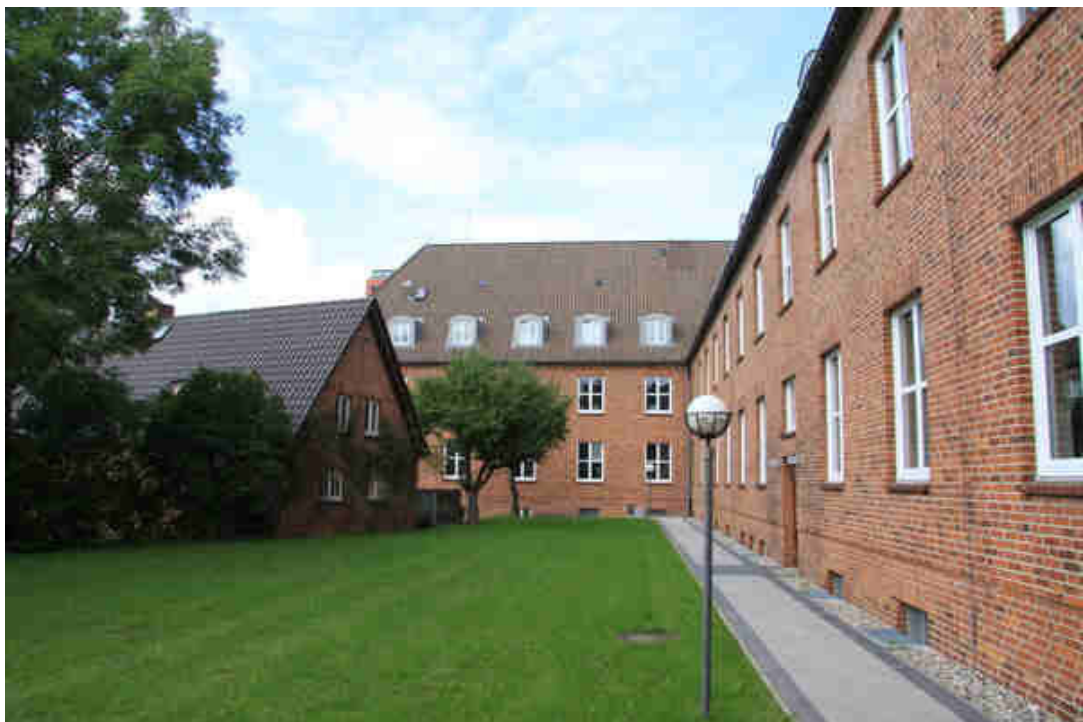
Bild 6: Westseite mit der Südfassade des nördlichen Querbaues am Gebäude D
