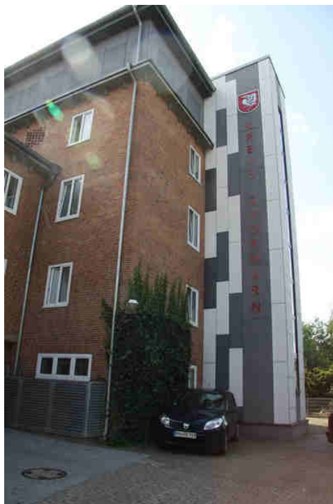
Bild 8: Nordgiebel des Gebäudes A mit Aufzugsschacht
