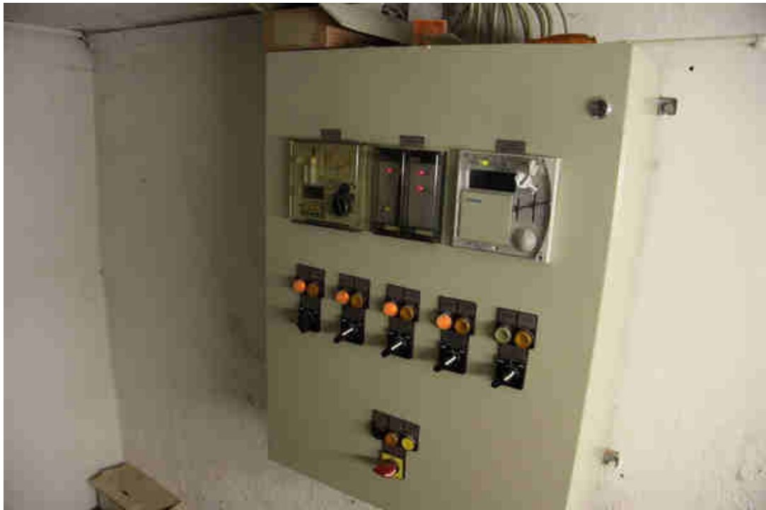
Bild 7: Veraltete Heizungssteuerung
