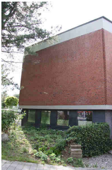
Bild 6: Süd-Seite des KT-Gebäudes
