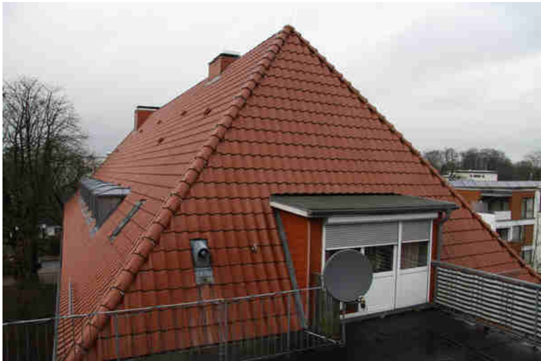
Bild 9: Dachansicht des Altbaus
