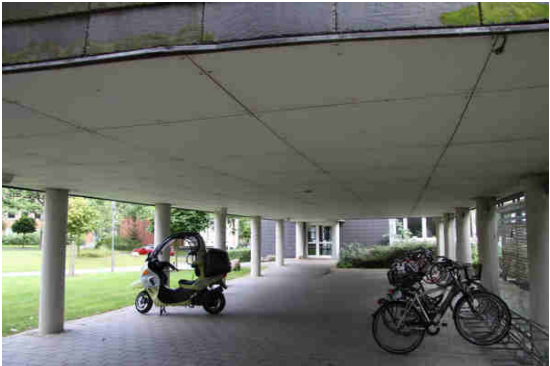
Bild 13: Verkleidete Decke des Verbindungsganges A-B
