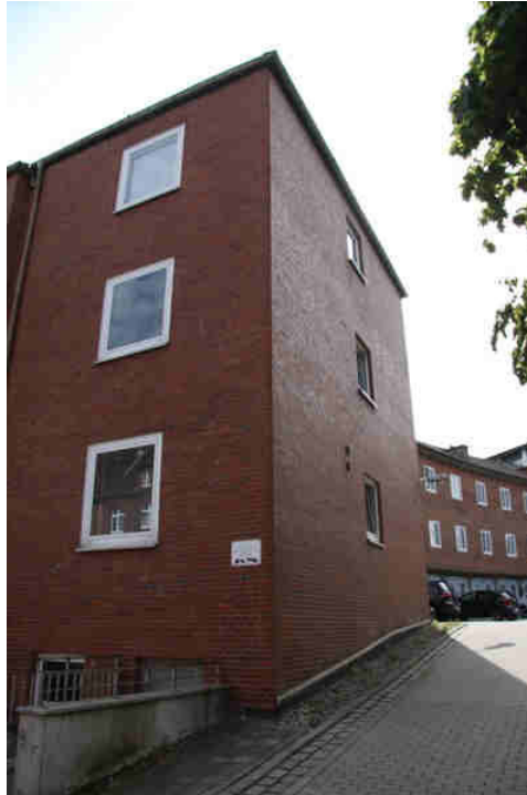
Bild 11: Nord-West Giebel des Gebäudes C
