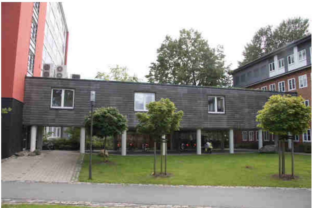
Bild 12: Nordseite vom Verbindungsgebäude A-B
