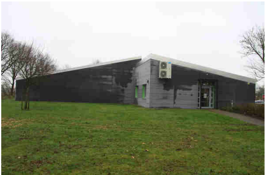
Bild 12: Ansicht auf die Westseite mit dem Klimagerät für die Klimatisierung des Gebäudes
