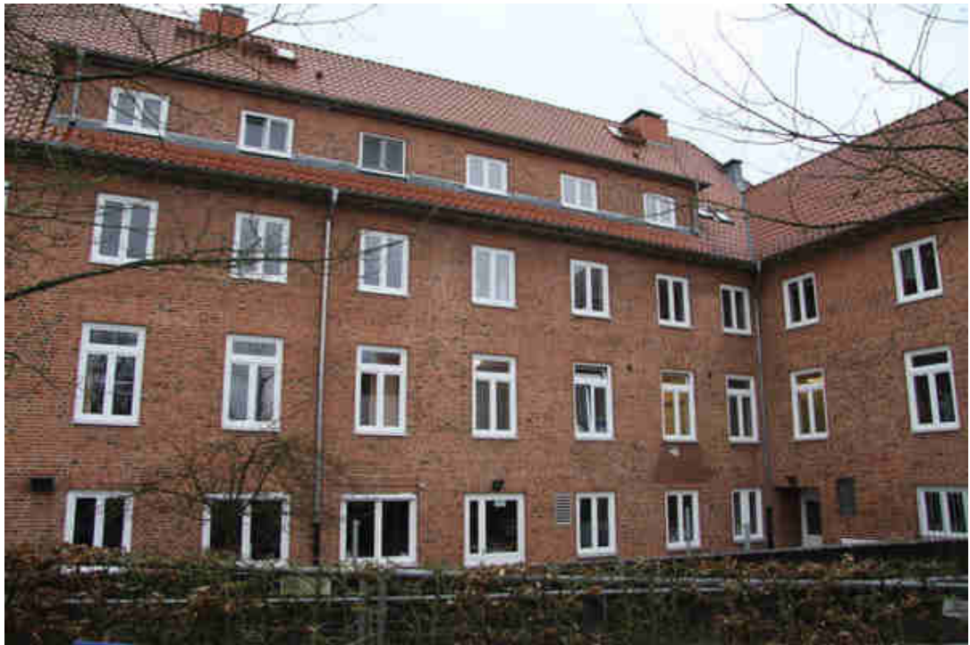
Bild 11: West- und Südseite des Altbaus
