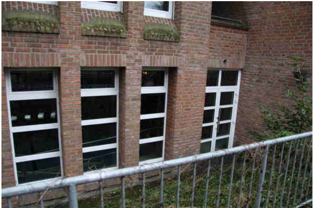
Bild 15: Fensteranlage des Schwimmbades im Untergeschoß in der Ostfassade
