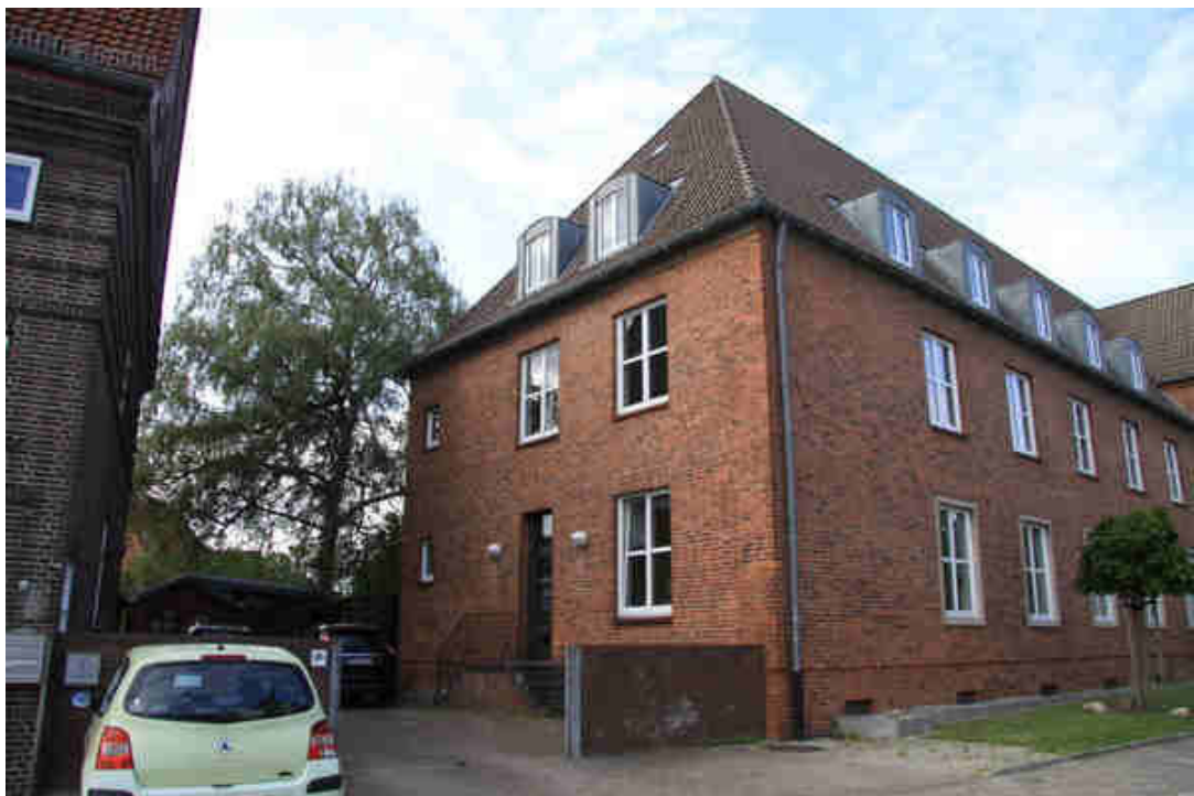
Bild 8: Südgiebel Gebäude D
