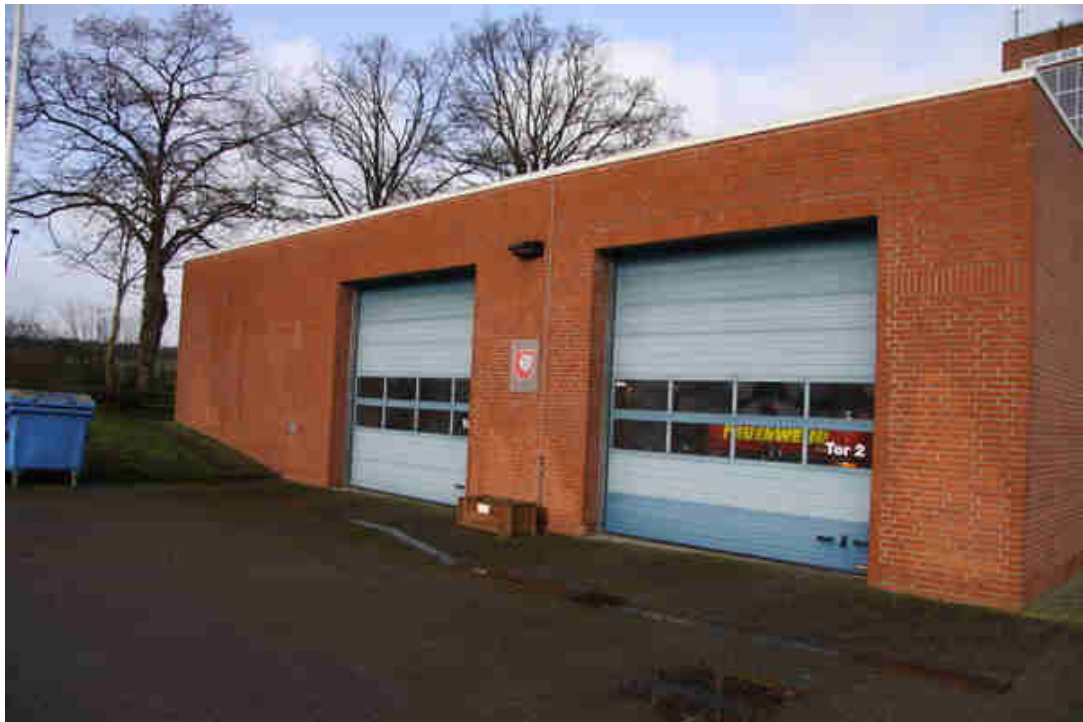
Bild 7: Südseite des Anbaus
