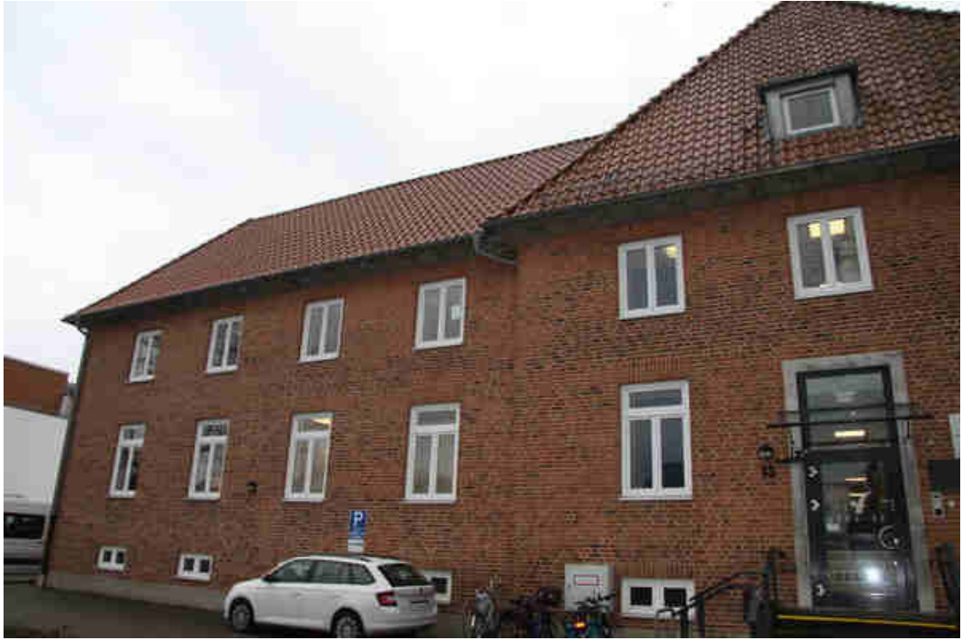
Bild 13: Nordseite mit Nordgiebel des Haupttraktes und seitlichem Anbau des Osttraktes
