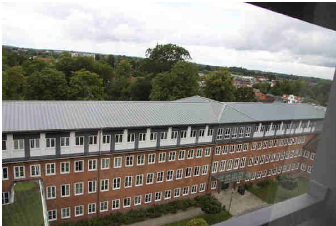
Bild 2: Ostseite des Gebäudes A mit nachträglicher Aufstockung
