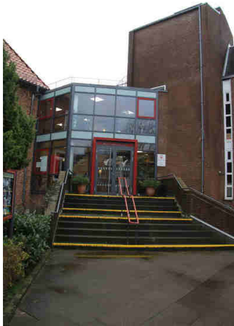
Bild 1: Haupteingang auf der Westseite und Verbindungsstelle zwischen Altbau BA 1 und Anbau BA 2
