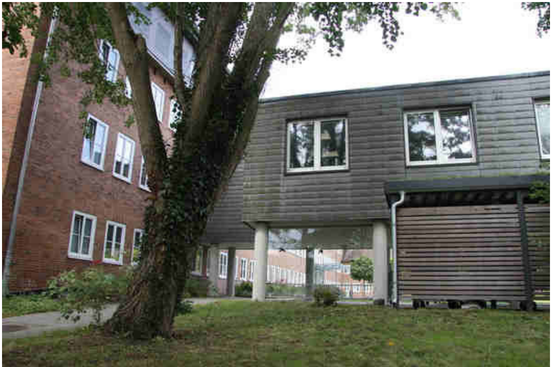
Bild 11: Südfassade des Verbindungsganges vom Gebäude A zu Gebäude B
