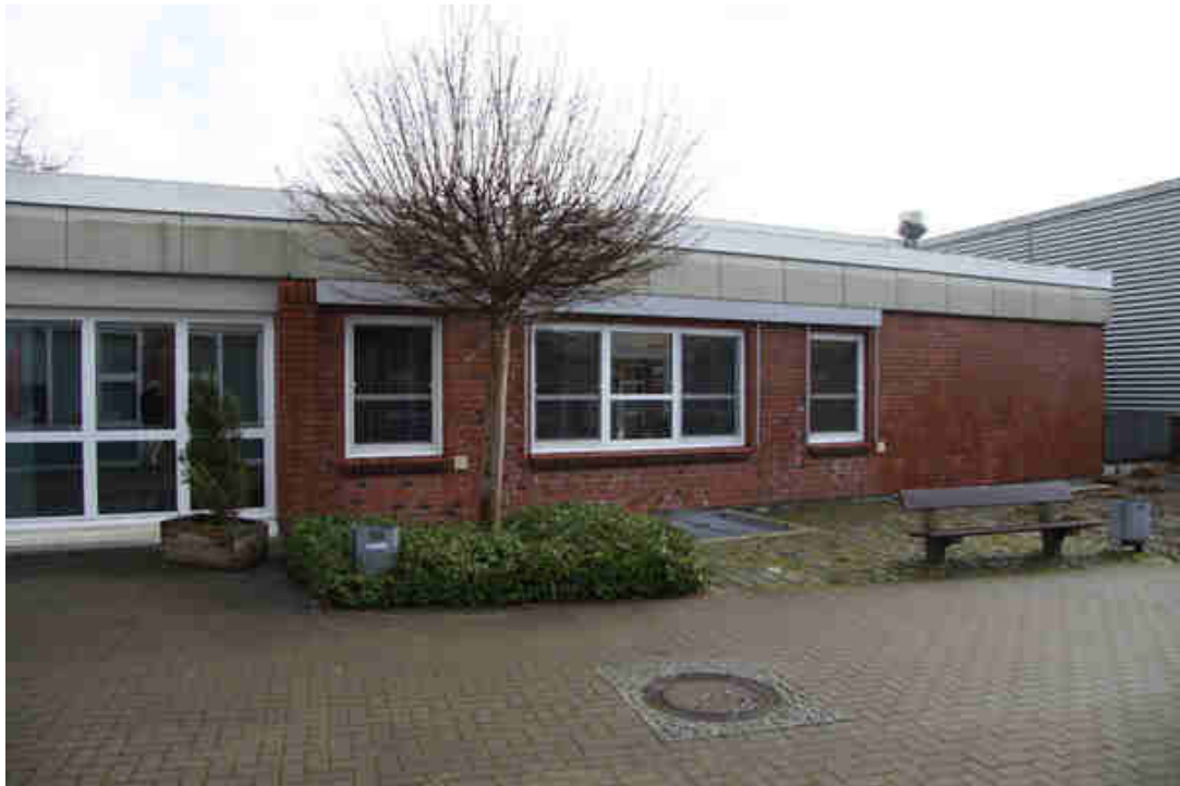
Bild 7: Westseite des südlichen Bürobereiches
