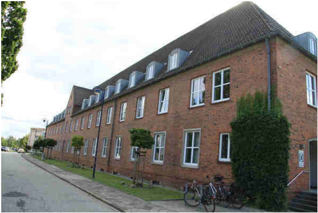
Bild 9: Ostseite des Gebäudes D
