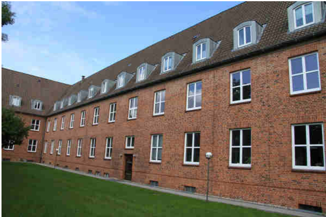
Bild 7: Westseite Gebäude D
