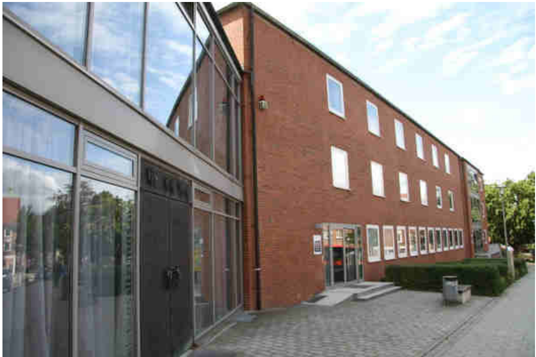
Bild 3: Nord-Ost Seite des Gebäudes C mit Glasfassade des KT-Gebäude
