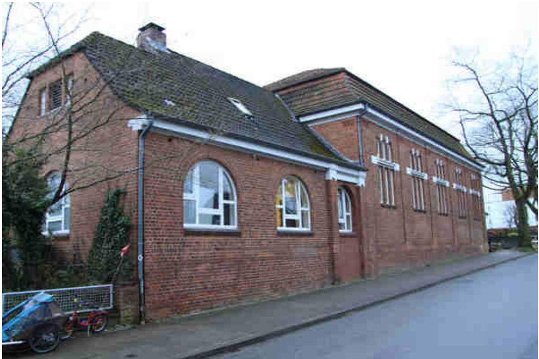
Bild 1: Nordfassade der alten Turnhalle
