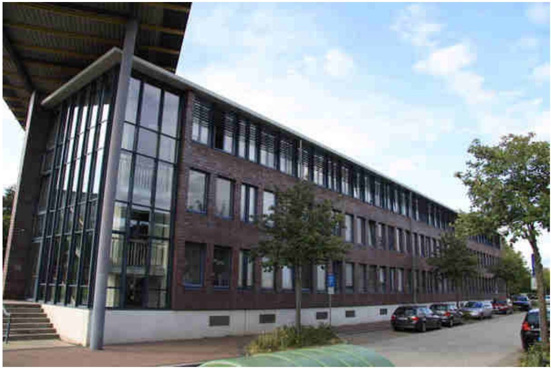
Bild 9: Westseite des Gebäudes
