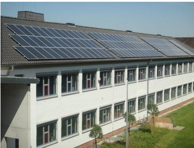
PV-Anlage berufliche Schulen Ahrensburg
