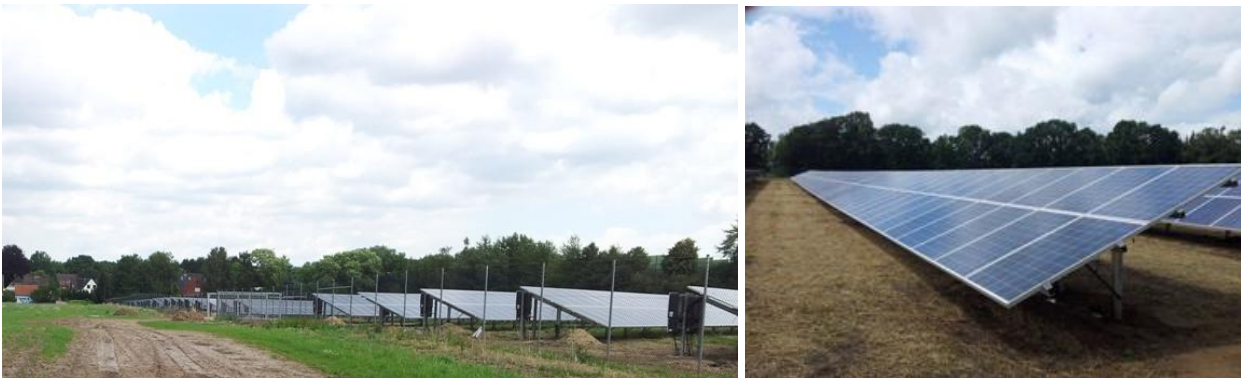
Solarpark Großhansdorf im Bau (Fotos CIC GmbH & Co KG)
