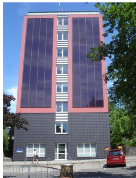
Fassaden-PV-Anlage Gebäude B
